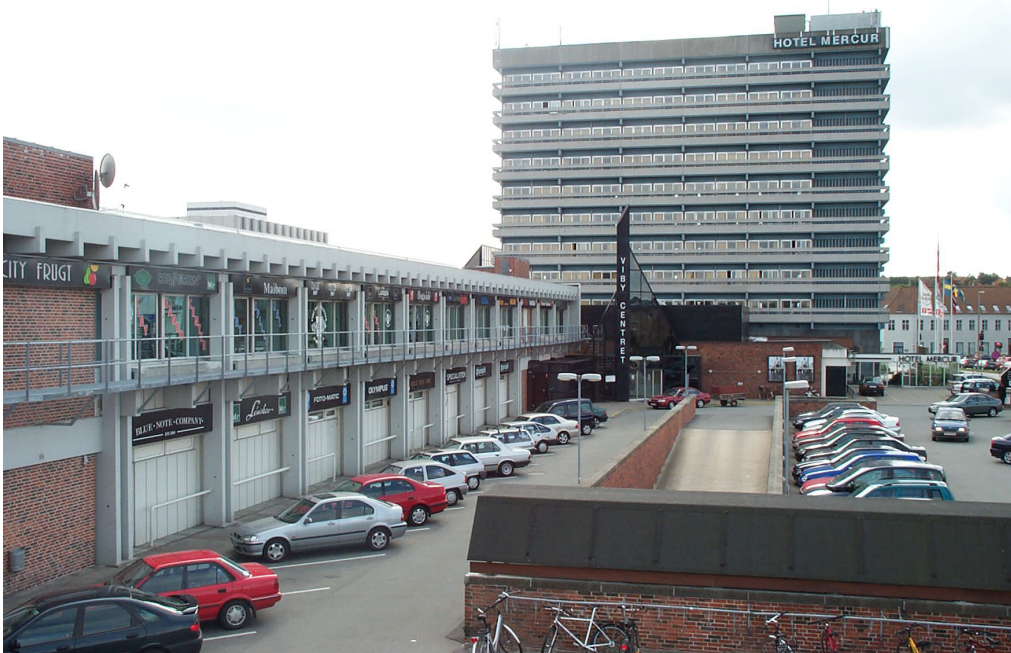
Figur 1.1 Viby Centret til venstre i billedet. Facade mod Viby Ringvej hvor Hotel Mercur kan ses i baggrunden.
